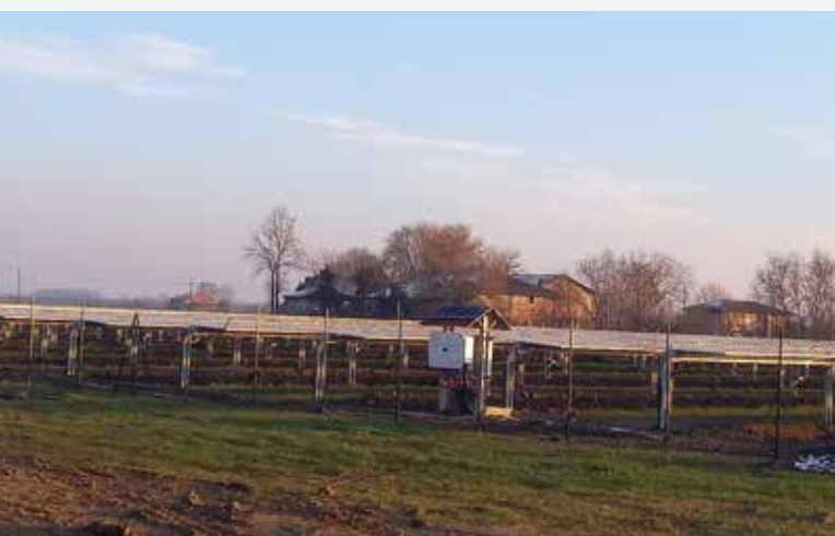
Foto A - Pannelli solari su suolo agricolo a S. Pietro in Casale, di tipo orizzontali, per massimizzare l'efficienza del sole e minimizzare l'ombreggiamento: spesso usati nell'agricoltura: offrono minore effetto del vento, cablaggio più concentrato, minore manutenzione.
