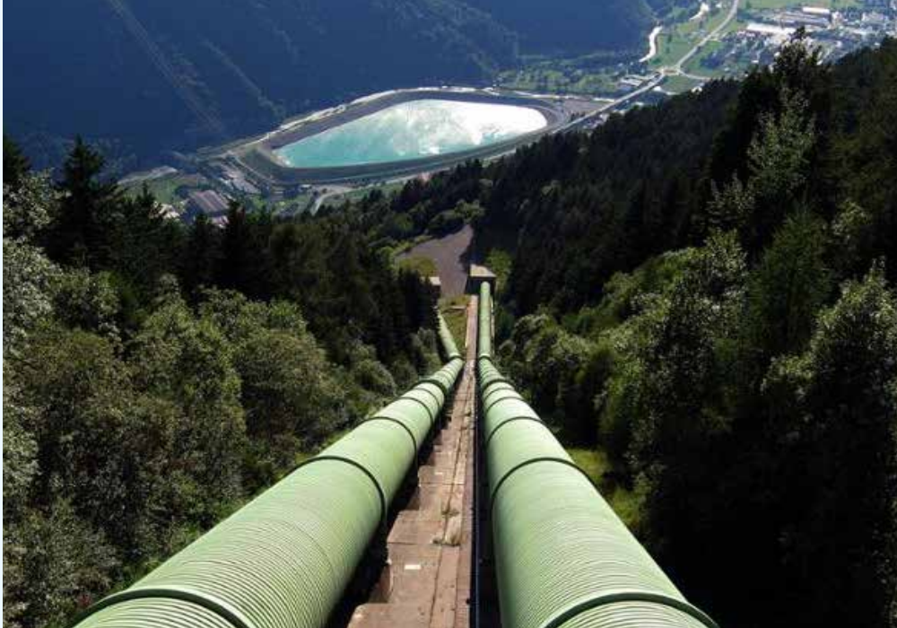
Edolo (BS) Valcamonica, la centrale idroelettrica di pompaggio è in grado di utilizzare l'acqua infinite volte mediante turbine e generatori reversibili. In Italia ne esistono 22.
